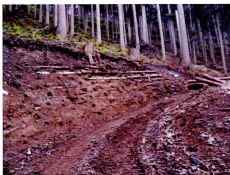
奈良型作業道
